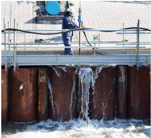
③水・エアにて杭間を洗浄
