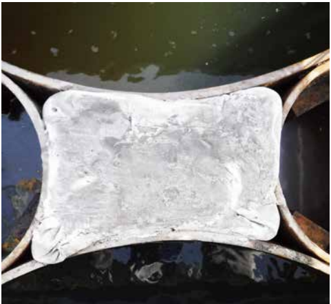
④モルタル硬化後
