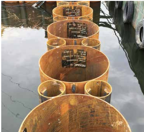
②圧入完了後
