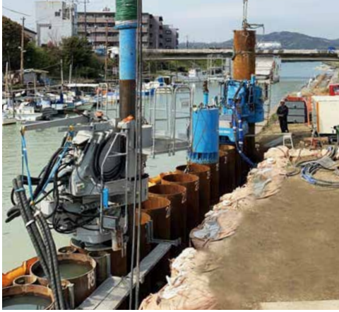
本杭との同時施工で工期短縮
