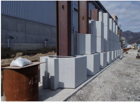
CSWブロック施工中
