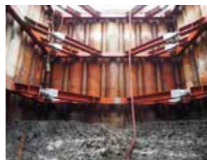
ジャイロプレス工法™による鋼管杭止水工法の確立
