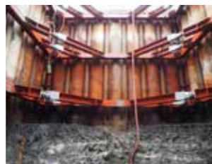
ジャイロプレス工法®による杭間止水工法の確立
