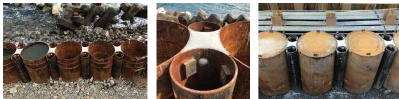
両側小口径鋼管による止水壁例
