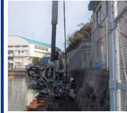
▲小口径管圧入状況
