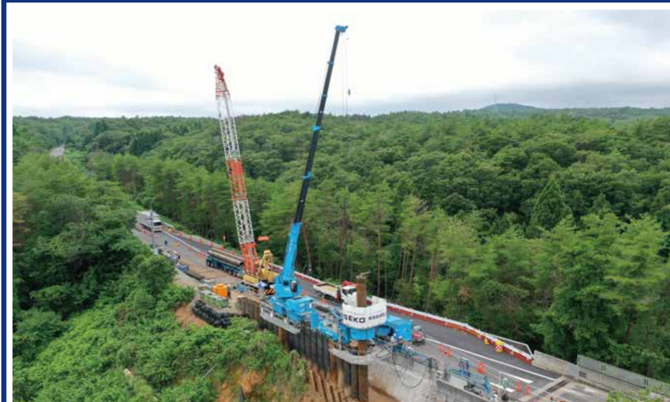
▲システム施工
