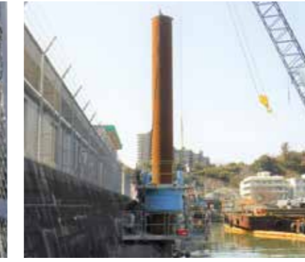
▲鋼管杭圧入状況
