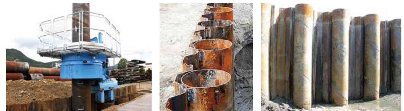
鋼管杭施工状況
