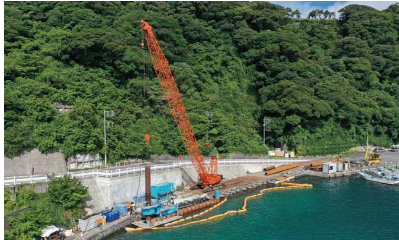
▲施工状況（全景）
