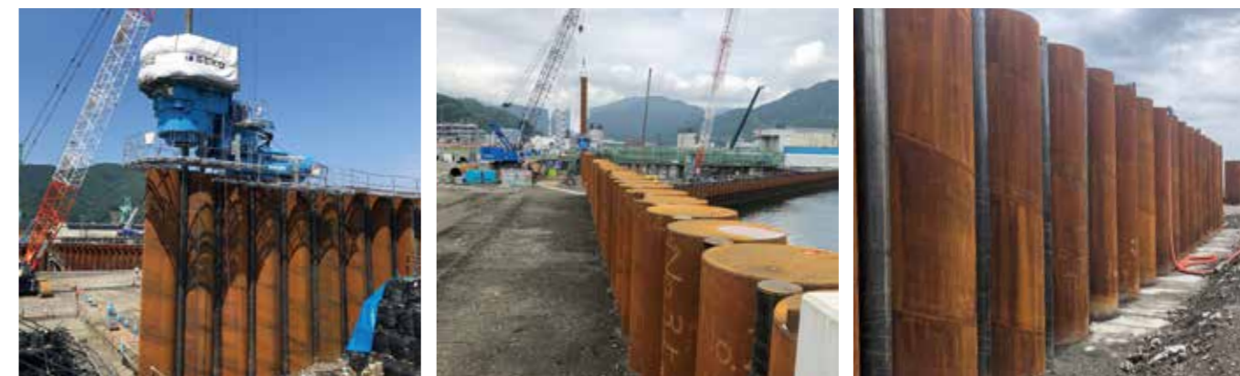
ジャイロパイラーによる小口径圧入（小口径チャック使用）
