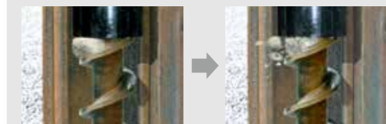
2 圧入完了 パイルオーガ引抜き
