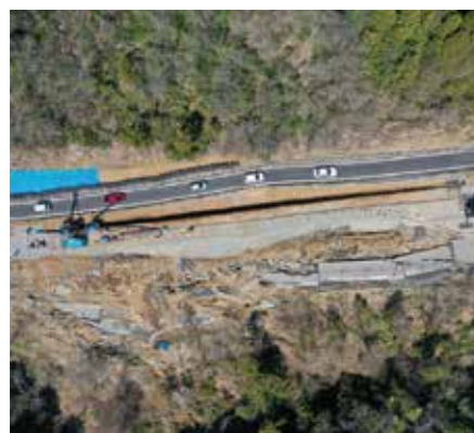
▲啓開済み道路への影響無く施工
