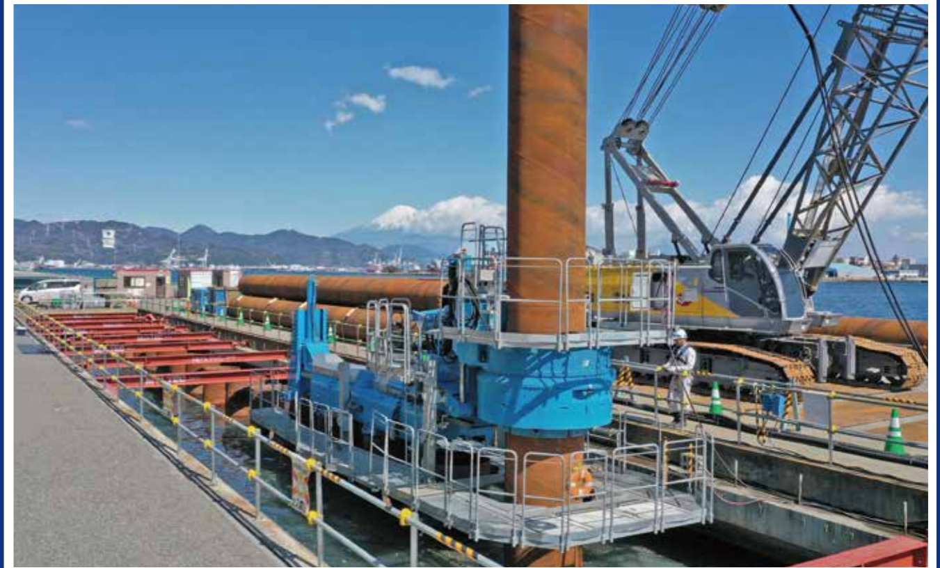
F401スキップロック仕様鋼管杭圧入
