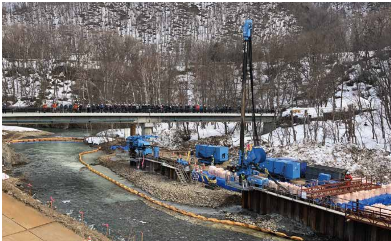
鋼管杭・鋼矢板同時施工
