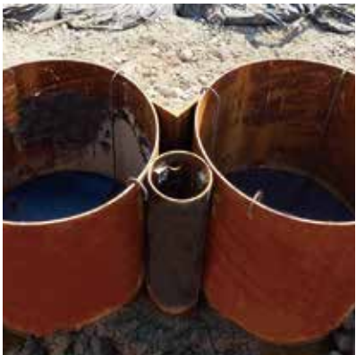
片側小口径による吸出し防止
