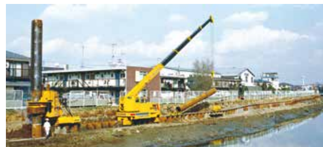
インプラント構造護岸を仮設レス施工で構築
