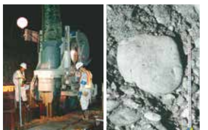
玉石混り層（100 - 300mm）への圧入
