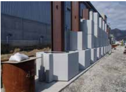
CSWブロック施工中
