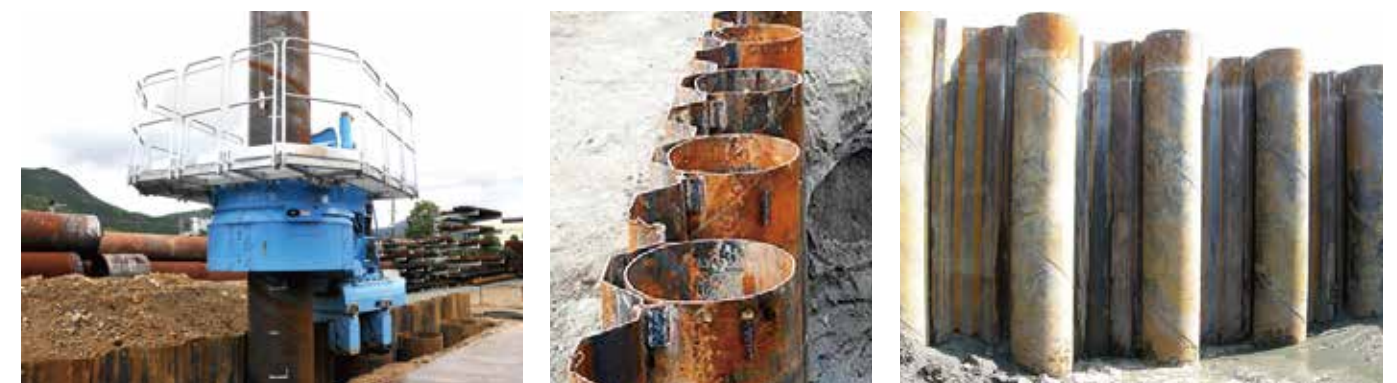
鋼管杭施工状況
