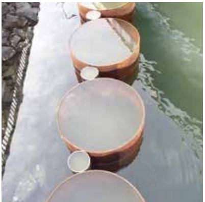
片側小口径による吸出し防止
