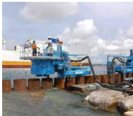
2台施工にて工期短縮
