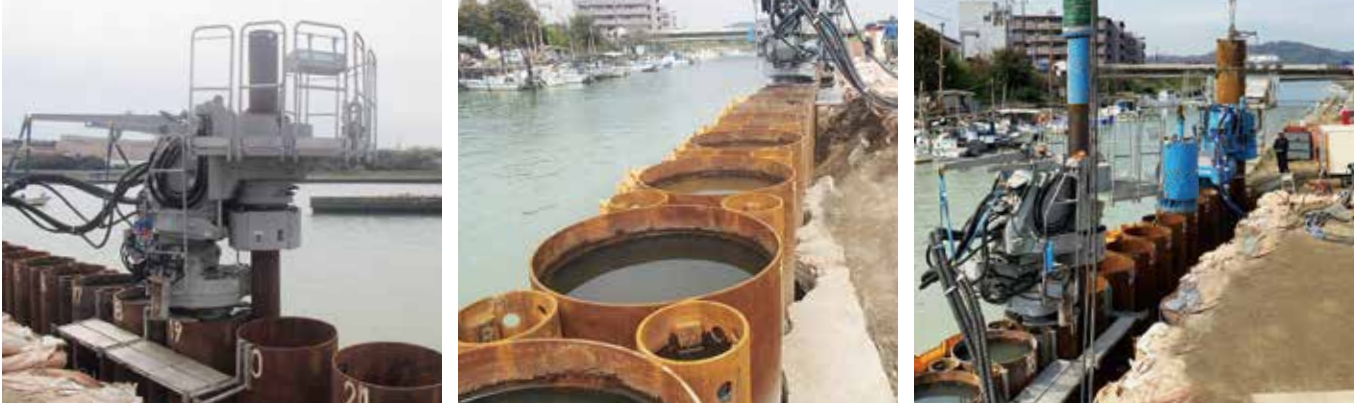
小口径専用圧入機 圧入状況 本杭との同時施工で工期短縮
