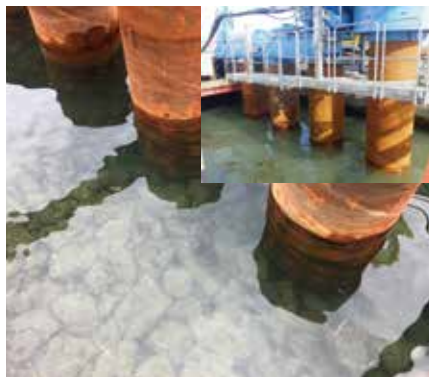
捨石貫入状況
