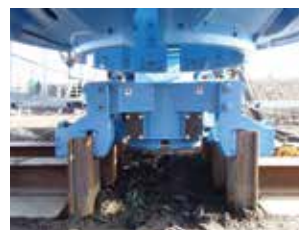
油圧クランプ式反力架台
