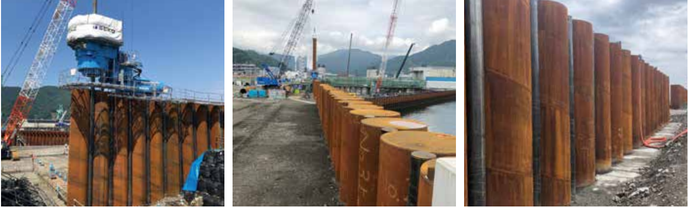
「ジャイロパイラー®」による小口径圧入（小口径チャック使用） 圧入完了
