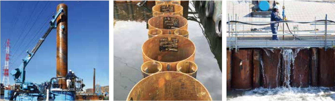
①上空制限下でも施工可能 ②圧入完了後 ③水・エアにて杭間を洗浄
