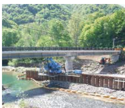
小口径鋼管圧入
