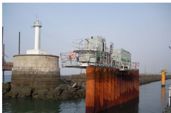
灯台付近はジャイロプレス工法で施工
