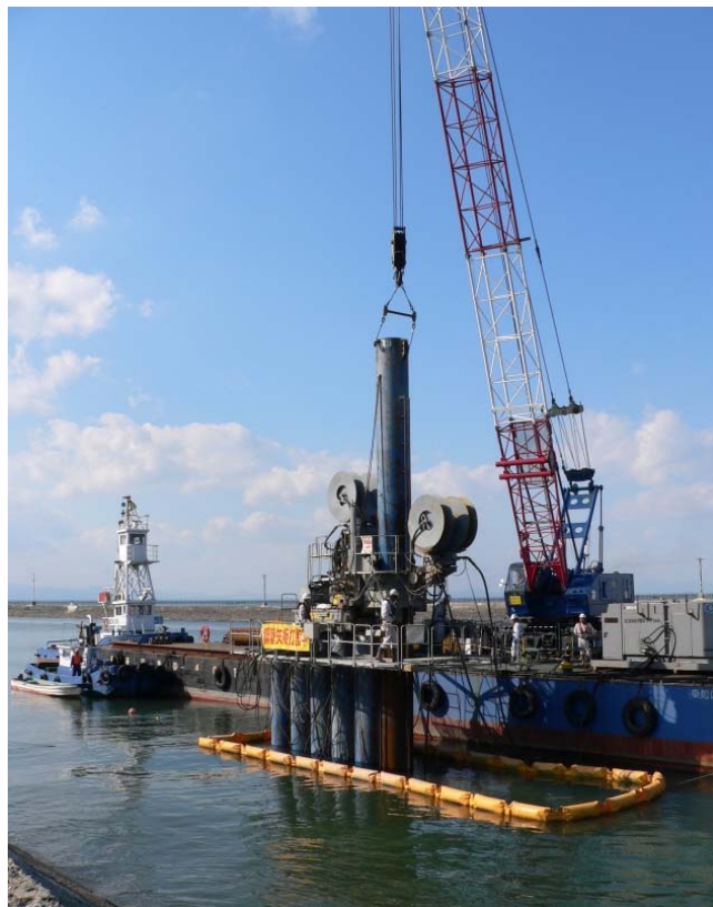
小型の台船とクレーンで施工可能
