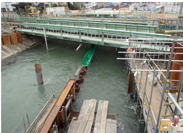
片側通水状態での水路築造状況
