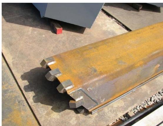
底板破碎用のビット付鋼矢板を作成して超低空頭ハ° 1 ーにて鋼矢板圧入前に底板を破碎した。
