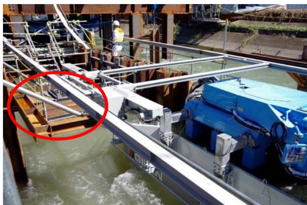
桁外部は H 鋼杭に取り付け
