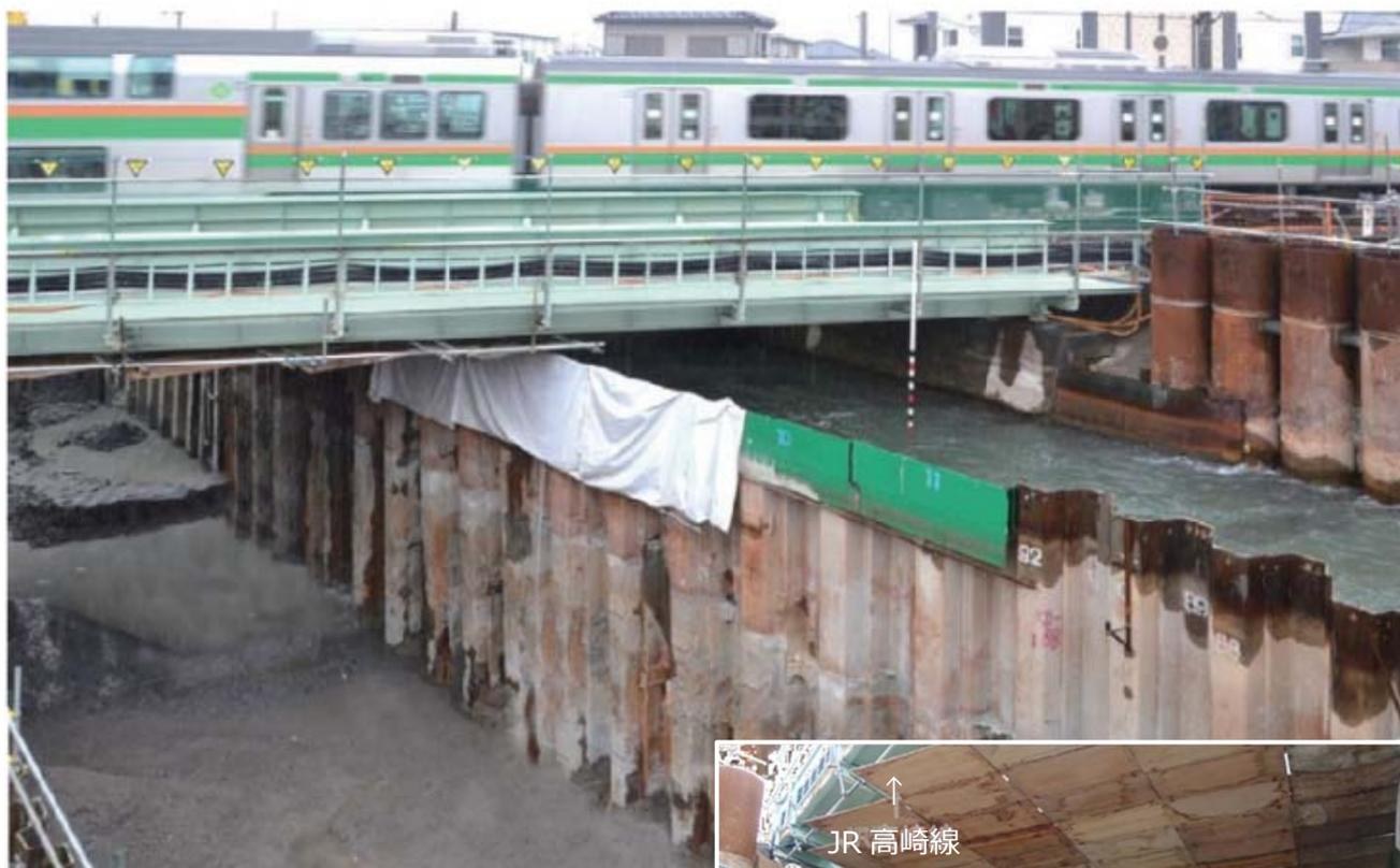
片側(右岸側)通水状況、横差し継手、縦継手ともに漏水なく完全止水できている。
