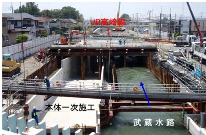
※施工完了した鋼矢板天端に FRP 製の嵩上げ板を設置して半川締切完了。
