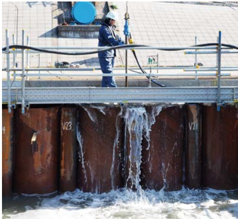
③水・エアにて杭間を洗浄
