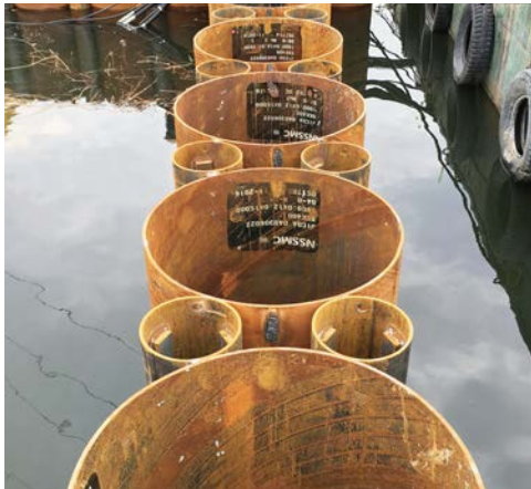
②圧入完了後
