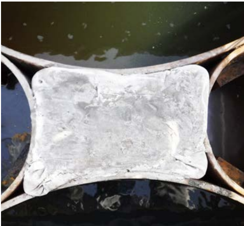
④モルタル硬化後
