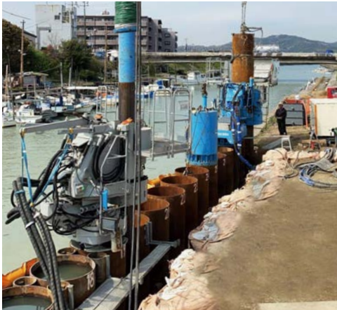
本杭との同時施工で工期短縮
