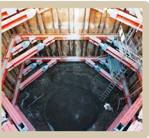
ピット内作業も支障なし（W.L-11.0m）
