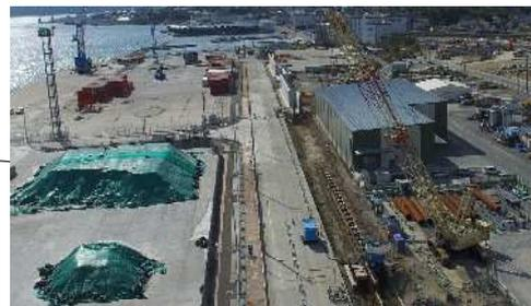
東日本大震災で被災した岩手県大船渡市の防潮堤復旧・新設作業の現場です。狭いスペースでの施工と硬い岩盤への打込みが必要な難しい場所でしたが圧入工法でスムーズな施工が実現しました。
