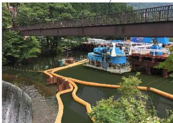
土砂災害防止のために造られ、登録有形文化財にも指定されている大源太川第1号砂防堰堤(さぼうえんてい)の現場です。完成後70年以上が経過し、老朽化の進んだ堰堤補強工事でしたが、自然に影響の少ない圧入工法で工事をを行い、景観を損なうことなく施工できました。
