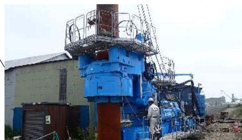
宮城県石巻港の復旧工事です。工場が隣接して重機が近づけない、漁港があるため泥水を流せないなど厳しい条件がありました。高難度の現場でしたが、技研力を駆使し圧入工法で完遂しました。
