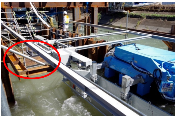
桁外部は H 鋼杭に取り付け
