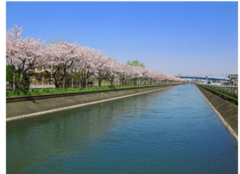
武蔵水路（行田市小玉地区）
