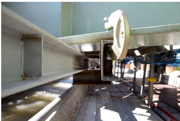
鉄道桁にレーンを直接取付け
