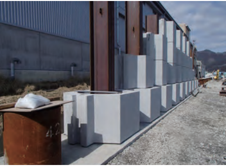
CSWブロック施工中
