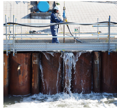
③水・エアにて杭間を洗浄
