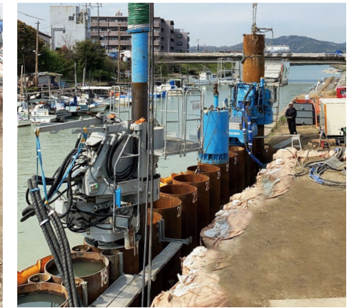
本杭との同時施工で工期短縮
