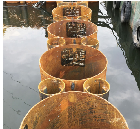
②圧入完了後
