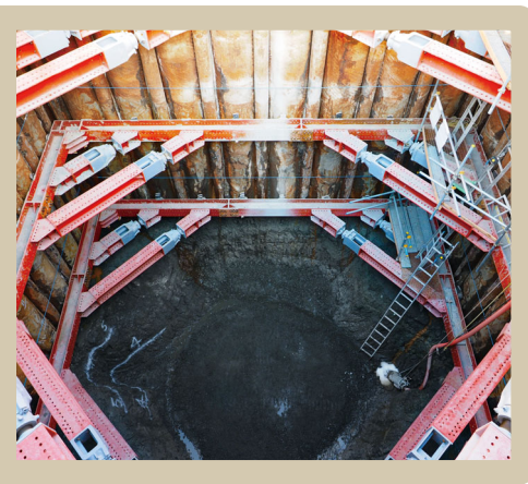
ピット内作業も支障なし (W.L-11.0m)
