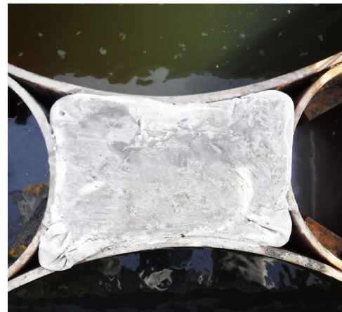
④モルタル硬化後
