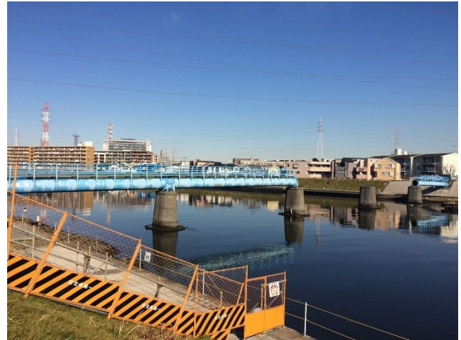
鶴見川水管橋周辺
