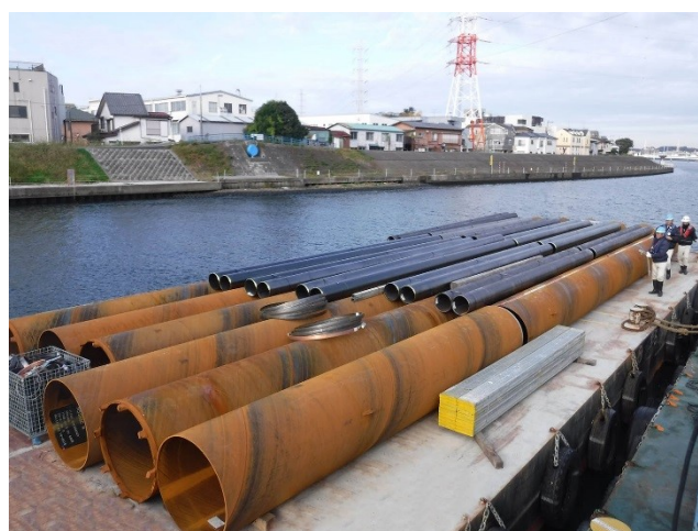
台船で資機材を搬入
