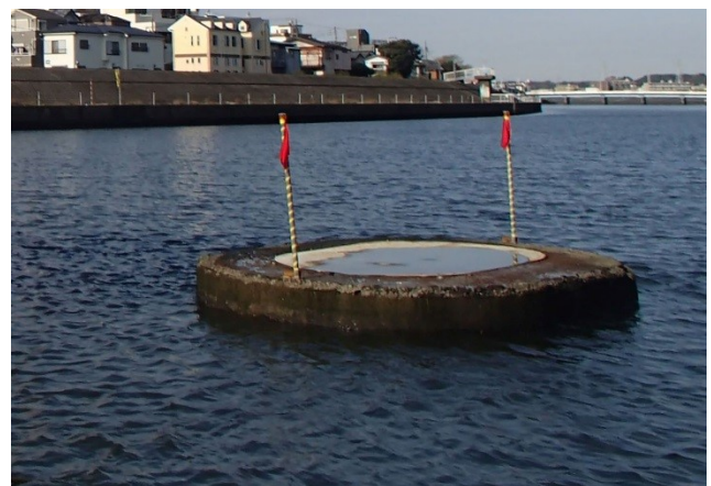
残置された橋脚
