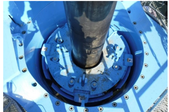
杭間先行掘削後に、鋼管杭を圧入し杭間パイプ把持用チャックアタッチメントを取り付け
