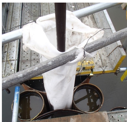
杭間にモルタル充填
