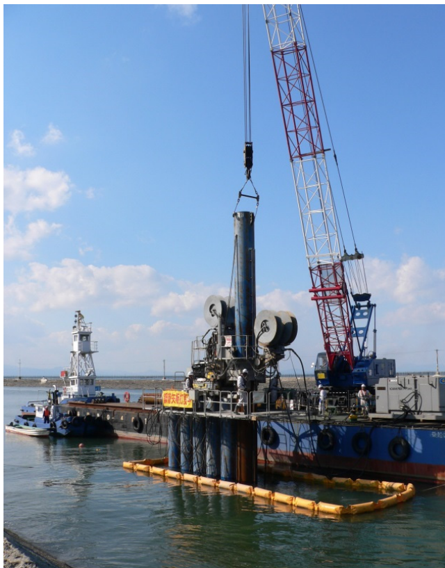
小型の台船とクレーンで施工可能
