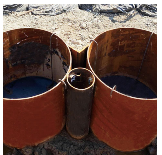
片側小口径による吸出し防止
