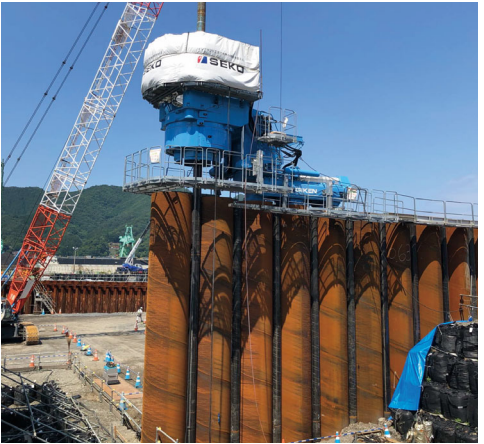
「ジャイロパイラー」による小口径圧入（小口径チャック使用）
