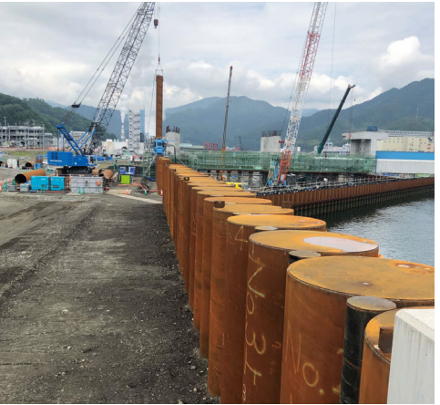
「ジャイロパイラー」による小口径圧入（小口径チャック使用）
