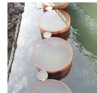
片側小口径による吸出し防止
