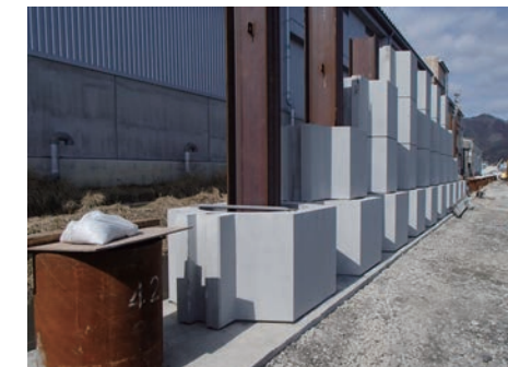
CSWブロック施工中
